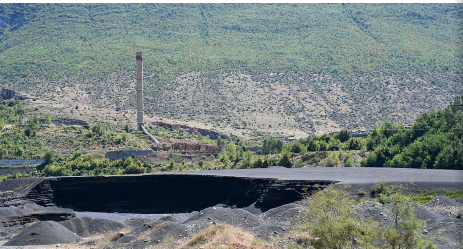
Inertet e ish-uzinës së shkrirjes së bakrit gërryhen çdo vit nga ujërat e liqenit që gjatë dimrit rrisin nivelin. | Foto: Erisa Kryeziu
